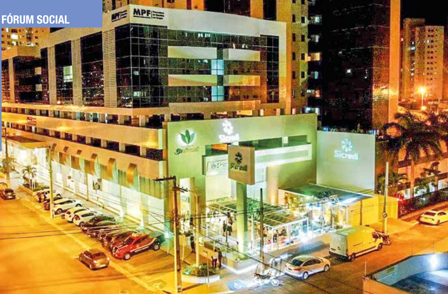
Fachada da nova sede destaca a Sicredi Aracaju em área nobre, no Bairro Jardins
