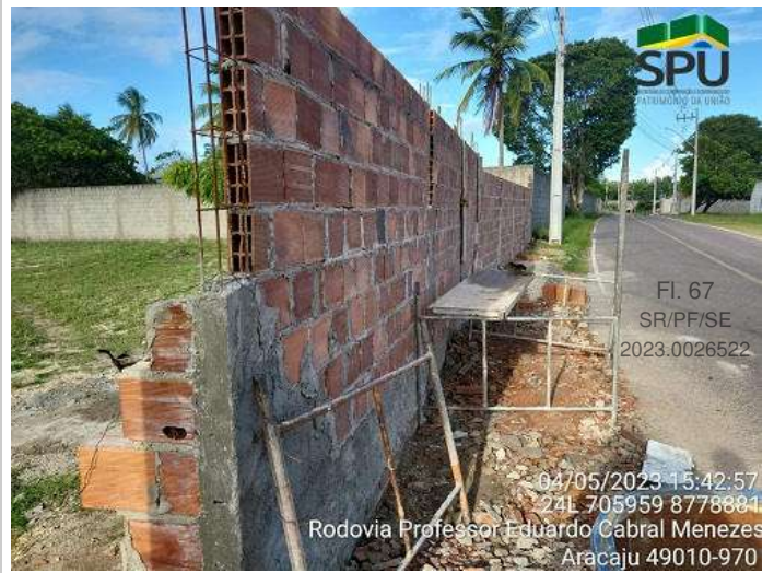
Fig. 2 - Muro em Construção
