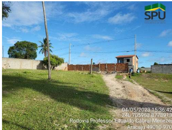
Fig. 3 - Vista do imóvel
