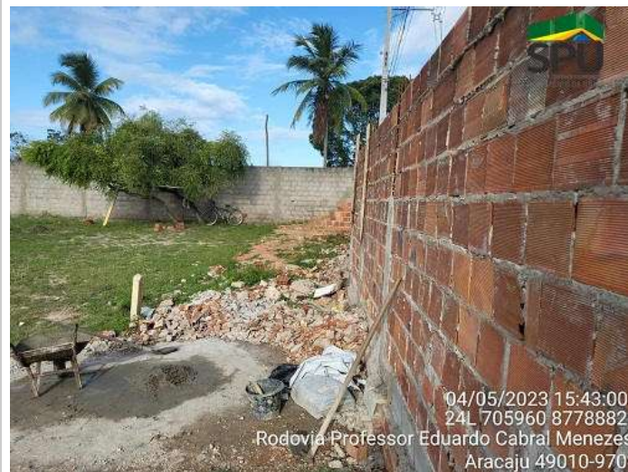
Fig. 9 - Muro em construção
