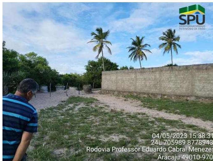
Fig. 5 - Vista do imóvel
